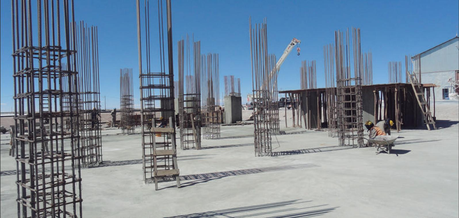
*Fundamentos de los silos de almacenamiento que se construyen sobre la superficie flotante en el Salar de Uyuni*
