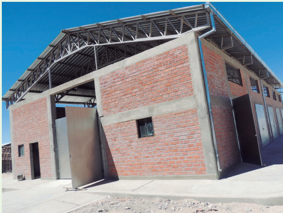
Galpón de selección y almacenamiento de residuos sólidos en el Salar de Uyuni
