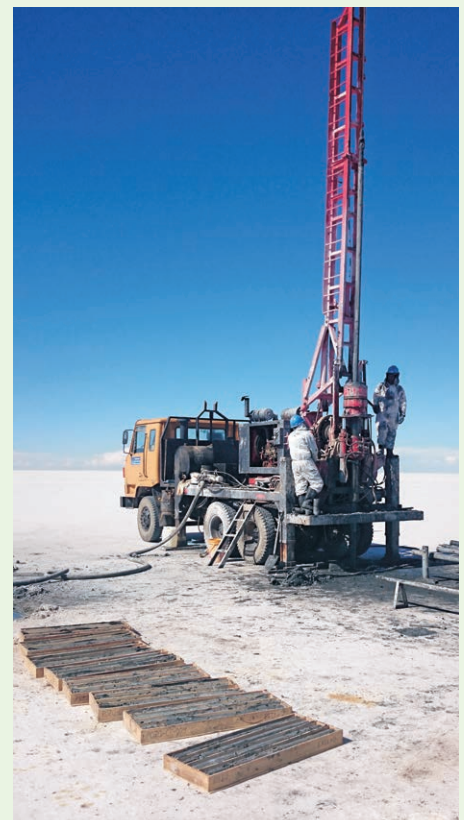
Perforación de pozos exploratorios a diamantina en el Salar de Coipasa
