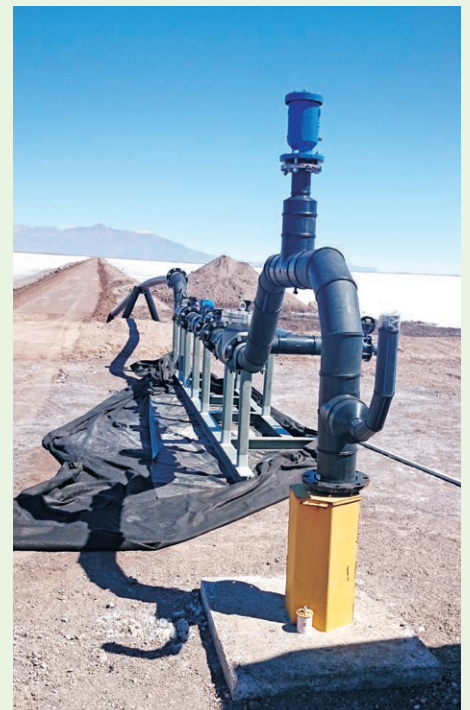
Instalación de pozo productivo para el bombeo de salmuera
