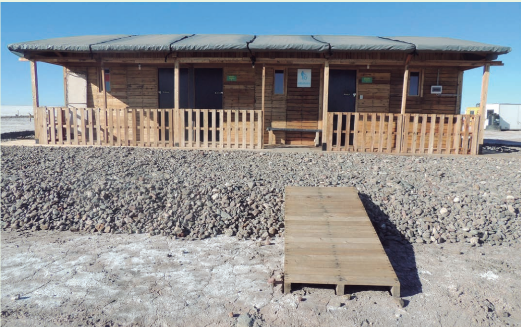
Módulo de Medio Ambiente, Seguridad Industrial y Salud Ocupacional en el Salar de Uyuni, construido con material reciclado de palets y restos de geotextiles
