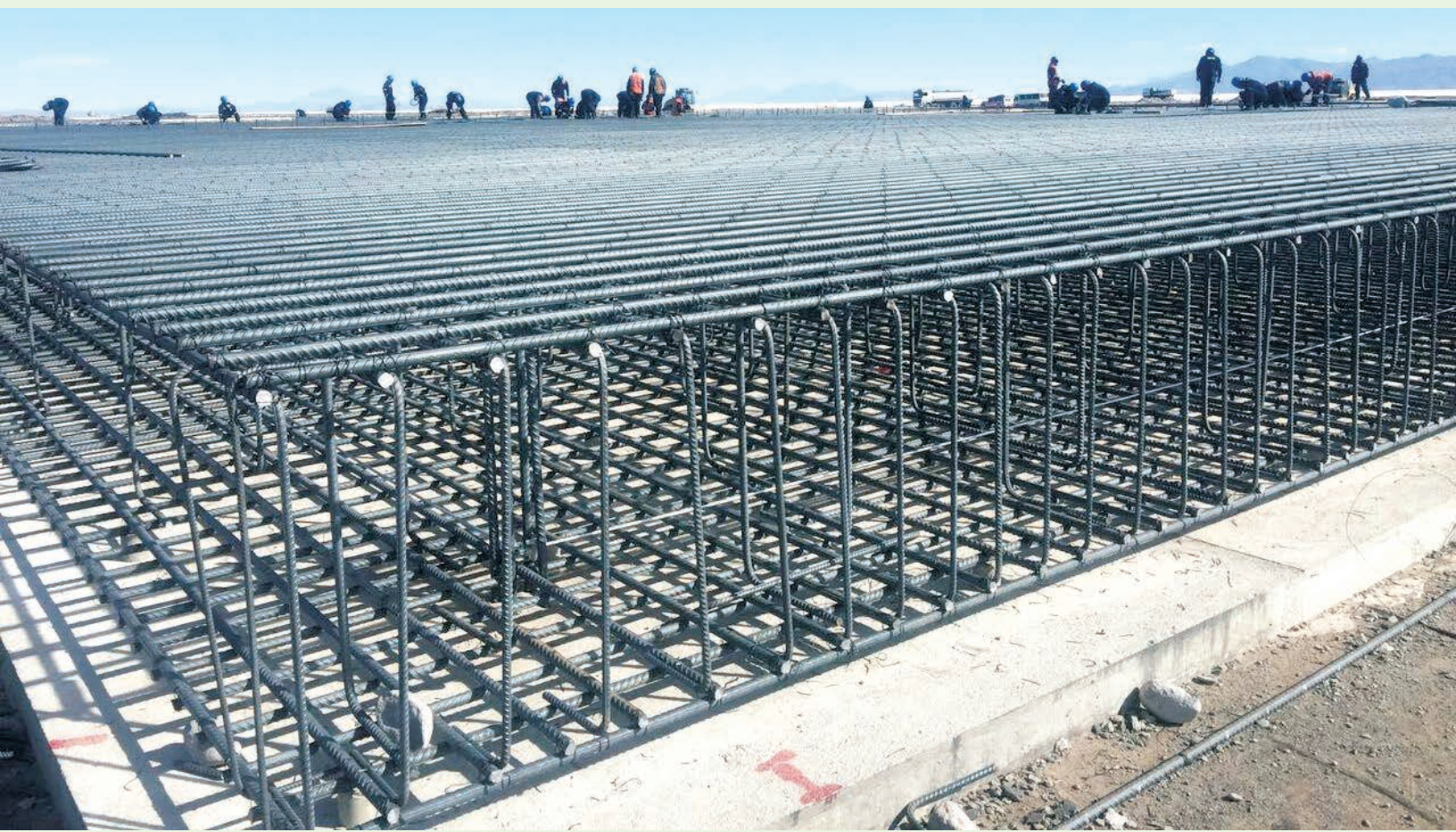
Estructura de la enfierradura de los cimientos de la Planta Industrial de sales de Potasio
