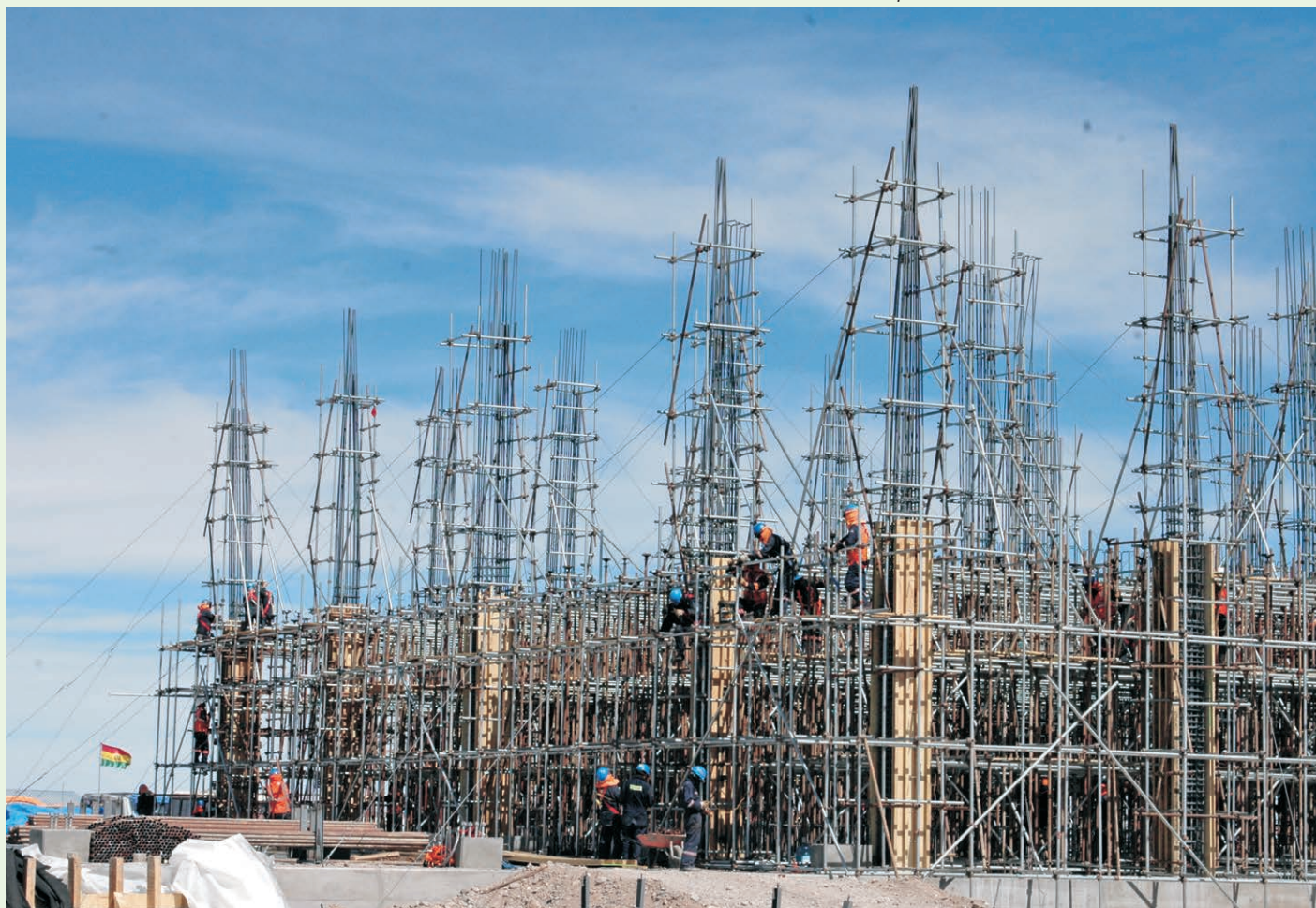
Enferradura del edificio de procesos de la Planta Industrial de sales de Potasio
