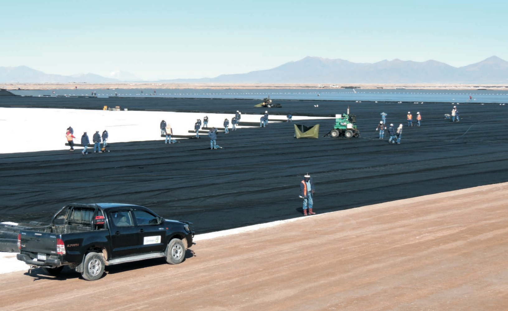
Impermeabilización de piscinas industriales
