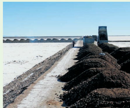
Construcción de piscinas industriales
