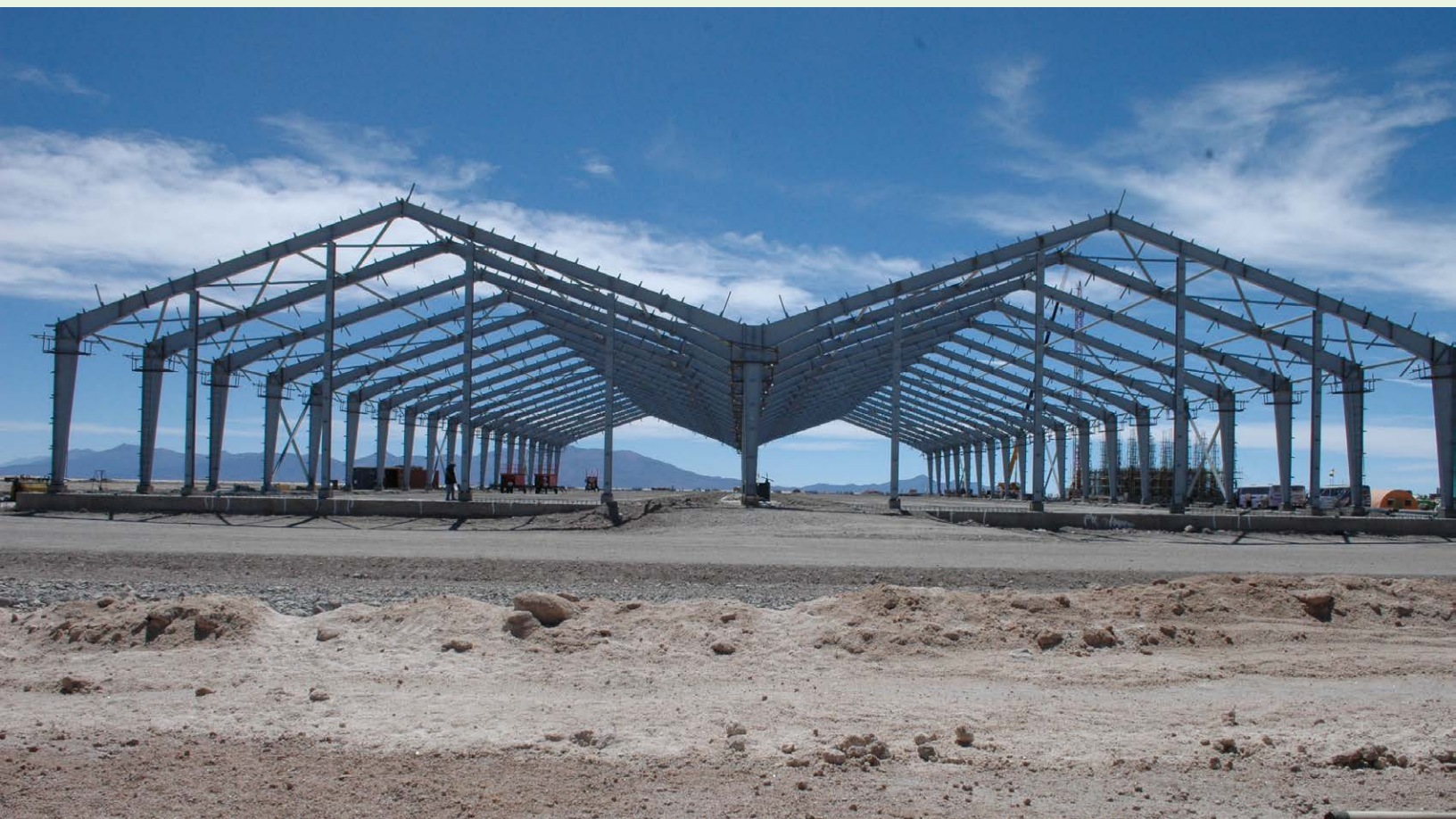
Estructura del almacen de producto final de la Planta Industrial de sales de Potasio
