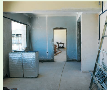
Reacondicionamiento de ambientes para el Centro de Investigación
