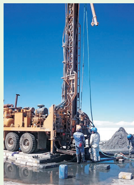
Perforación de pozos exploratorios a circulación directa en el Salar de Coipasa
