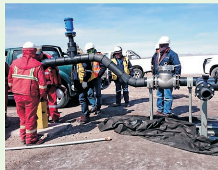
Instalación de red de bombeo en circuito de piscinas industriales
