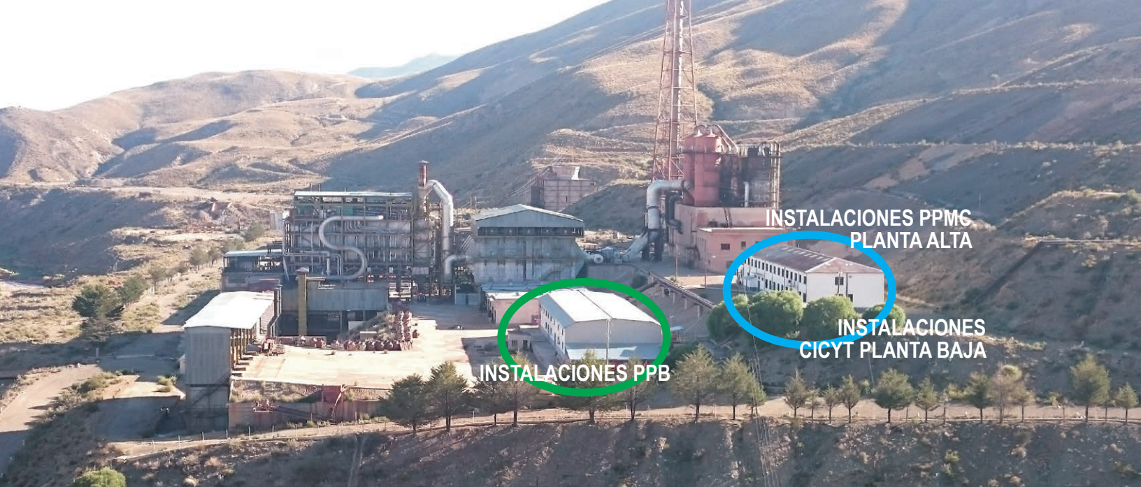
Vista panorámica de instalaciones de la Planta Piloto de baterías de Litio en La Palca - Potosí
