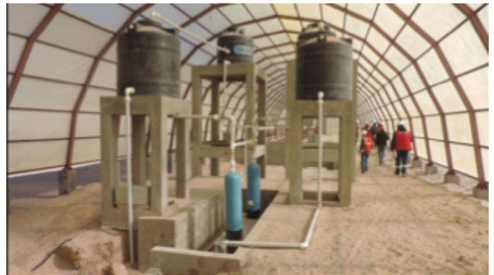
*TANQUES ELEVADOS DE HºAº PARA ALMACENAMIENTO DE AGUA TRATADA, PARA ALMACENAMIENTO DE REGENERANTES, INFRAESTRUCTURA PARA DESIONIZADORES (+) Y (-) Y DESIONIZADORES.*
