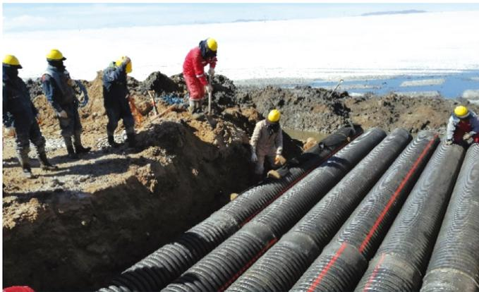
Instalación de tuberías HDPE para alcantarillas
