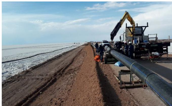
Instalación de tuberías en sector de piscinas
