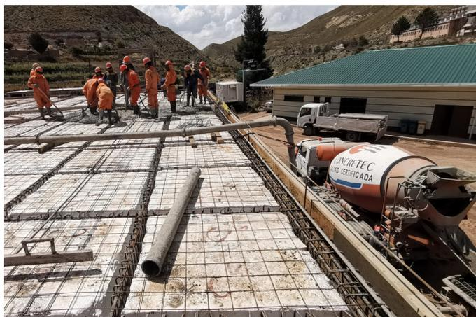
Vaciado loza de hormigon armado, construcción Centro de Investigación CICYT MAT REB
