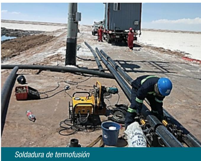
Soldadura de termofusión
