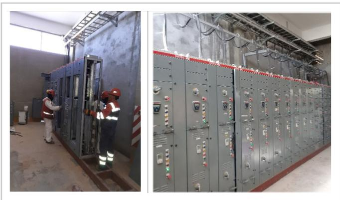
*Montaje de tableros CCM Planta Piloto de Carbonato de Litio*
