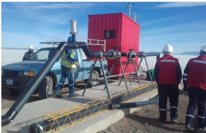
Montaje de manifold en estación de bombeo
