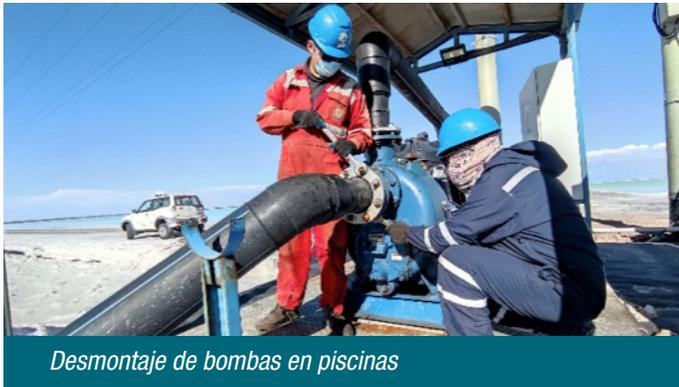
Desmontaje de bombas en piscinas
