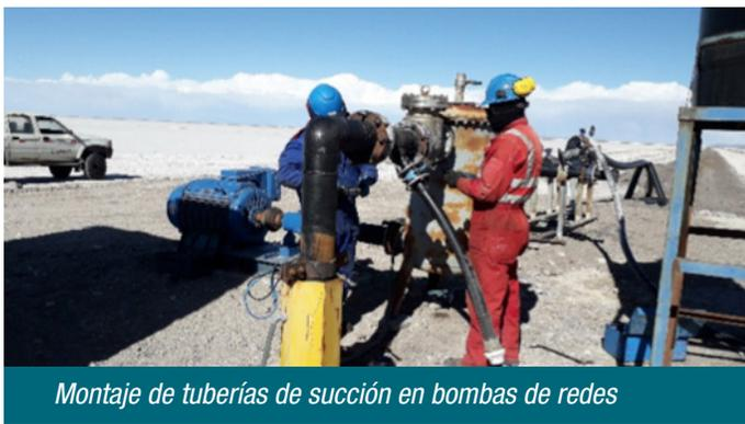
Montaje de tuberías de succión en bombas de redes
