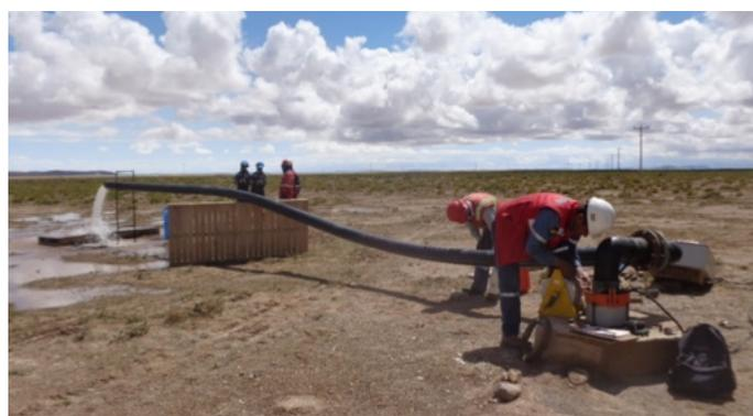
Figura 3. Medición de los parámetros hidráulicos de los pozos.
