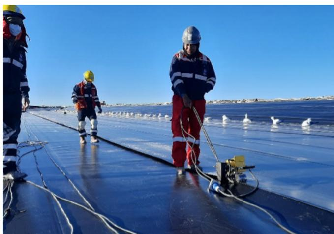
Soldadura por termofusión de láminas de geomembrana
