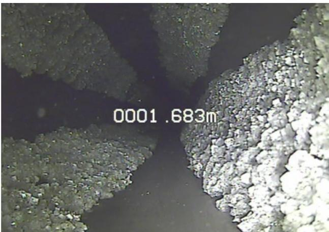
Figura 5. Vista parcial de la columna de pozo de producción de salmuera con precipitación de sales en los filtros.
