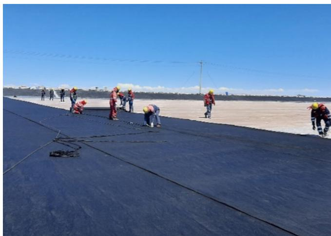
Instalación de geotextil tipo 1
