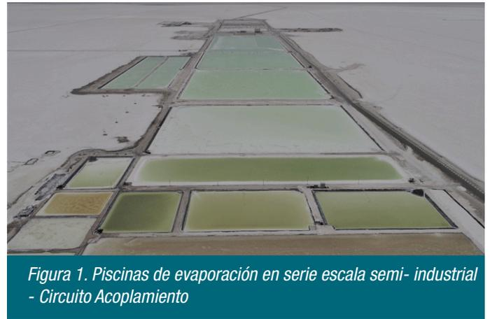
Figura 1. Piscinas de evaporación en serie escala semi- industrial - Circuito Acoplamiento
